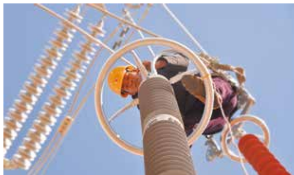
平地泉 220 千伏变电站 - 察右前旗牵引站施工现场图
