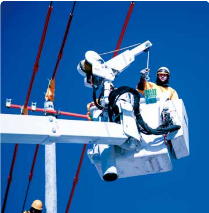
开展带电作业
